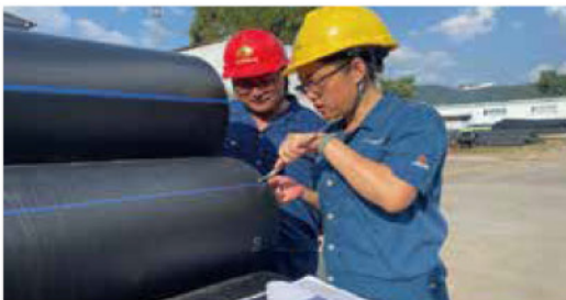
圖:德銅實業公司管道質量檢測
