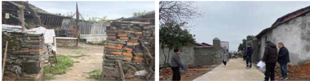
圖：後山區01棟房屋整治前後
